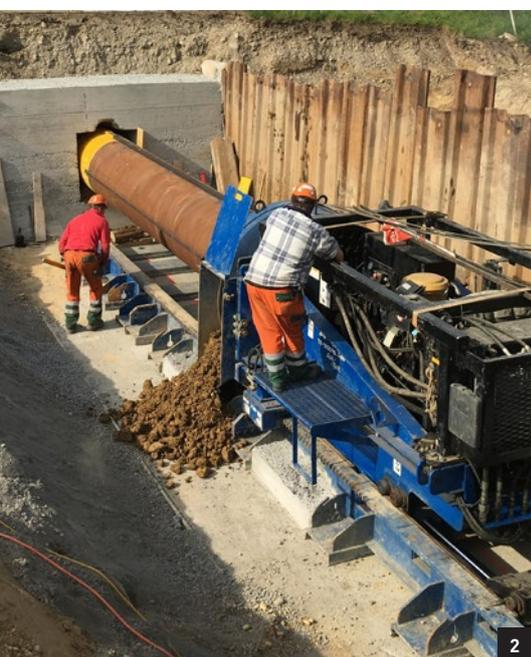
Als Lösung wurde ein Stahlrohr-Pressbohrvortrieb DN 1000 mit einem GFK-Rohr-Inliner vorgeschlagen, der nach genauer Prüfung durch das ASTRA genehmigt wurde.
