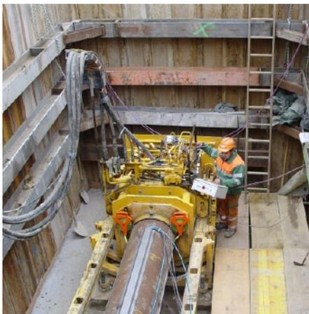
Pressvortrieben, Bohrachskorrekturen in horizontaler und vertikaler Richtung möglich und kontrollierbar.
