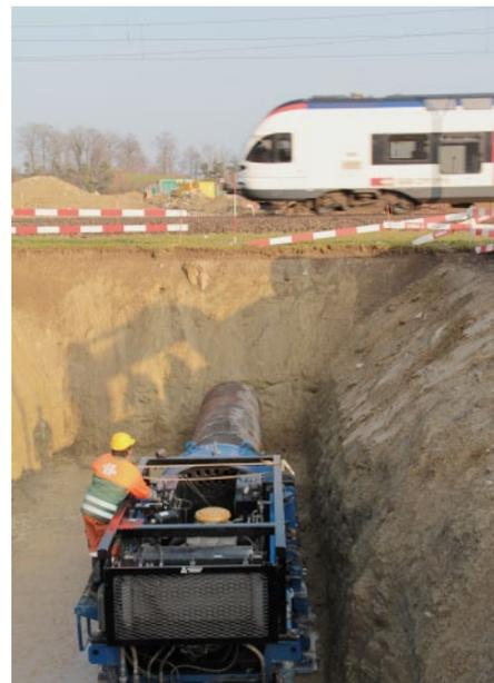
wurden, auf einer Länge von 45 m, SBB- und Industriegeleise unterquert.
